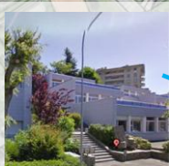
Collège Mont-Goulin Chemin de sous-Mont 6-8
