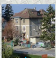
Château 1 Avenue du Château 1
