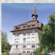
Collège Centre - Sud Place du Collège 3
