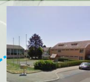
Collège Jolimont Avenue Jolimont 32
