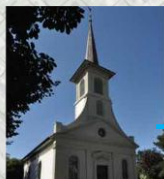
Temple de Broye Chemin des Planches 4
